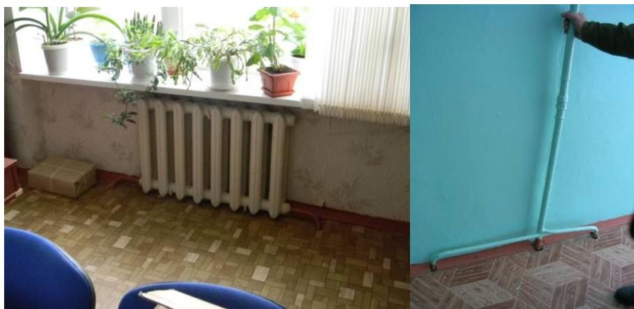
*Рис. 2. Установка отопительных приборов и подающего стояка*
