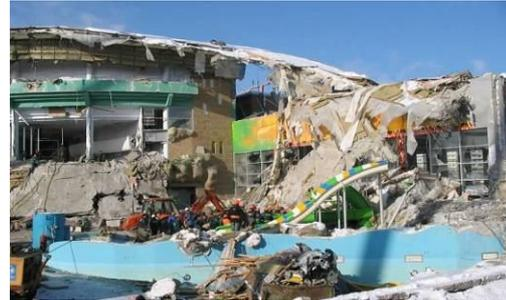
*Рис. 6. Обрушение кровли плавательного бассейна «Дельфин», г. Чусовой*
