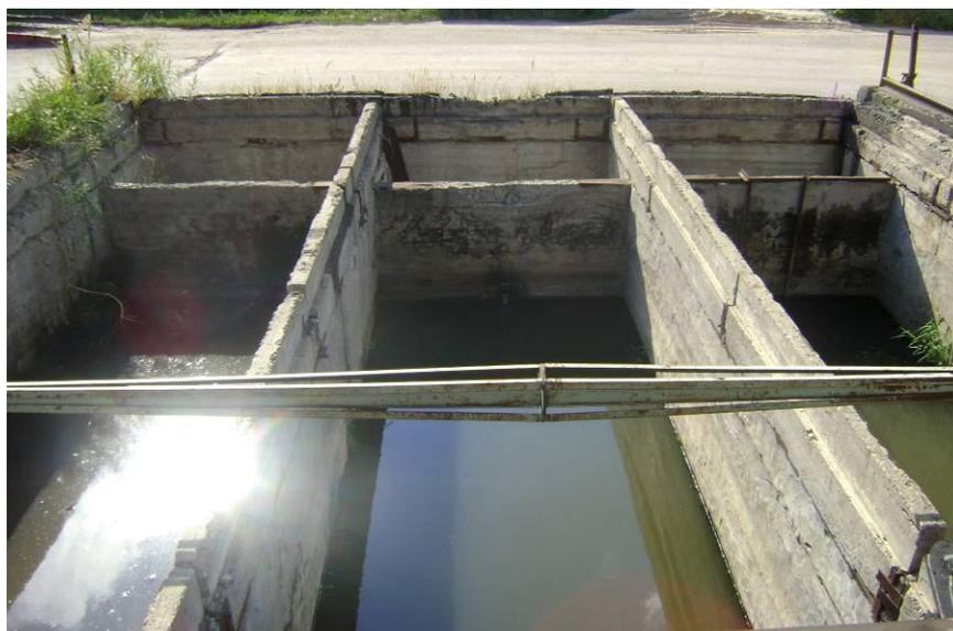
Рис. 2. Горизонтальный отстойник с перегородками
