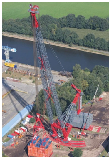
Рис. 4. Кран компании «Abnormal Load Engineering Ltd» (ALE)
