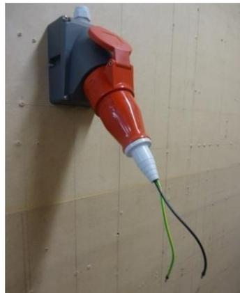
Подготовленные разъемы соединяется с соответствующими разъемами ЭУ. К полученным проводникам подключаются электроды мегомметра. Напряжение – 250, 500В.
