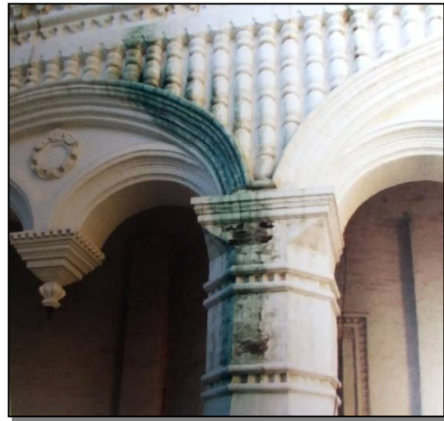
Рис. 1. Разрушение на фасаде в результате неконтролируемого сбора воды с крыши
