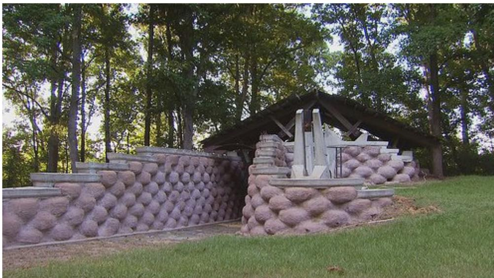
Рис. 2. Здание из отработанных автопокрышек
