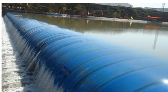
Рис. 5. Водоналивная дамба
