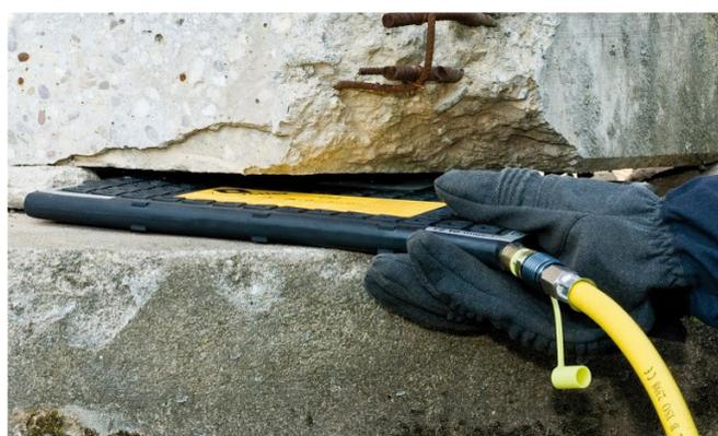
*Рис. 9. Применение пневмодкрата при усилении фундамента здания*
