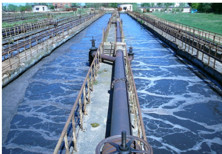
Рис. 1. Аэротенк
