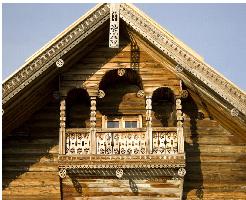
Рис. 1. Пропиленная резьба. Фрагмент деревянного дома Яковлевых. Музей деревянного зодчества Киж
