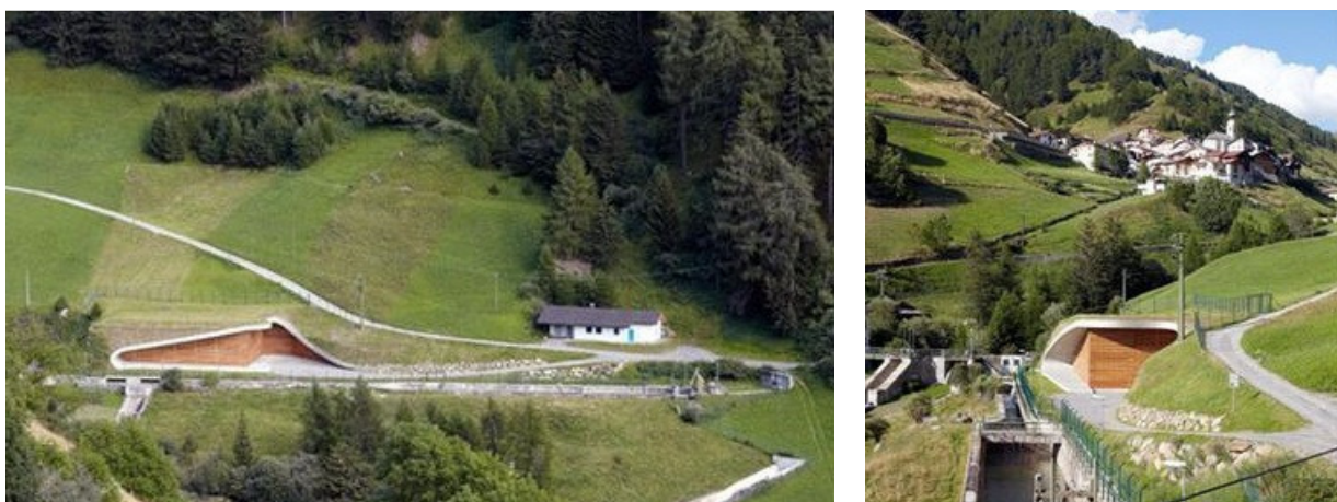
Рис. 3. Гидроэлектростанция Yet Noninvasive Hydroelectric Power Plant, Южный Тироль, Италия
