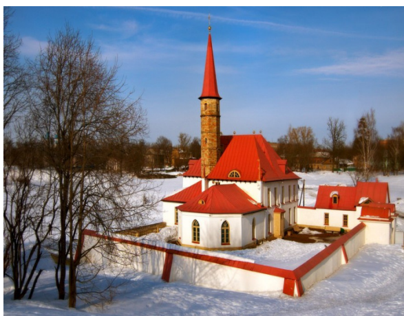
Рис. 3. Землебитная технология – Приоратский дворец
