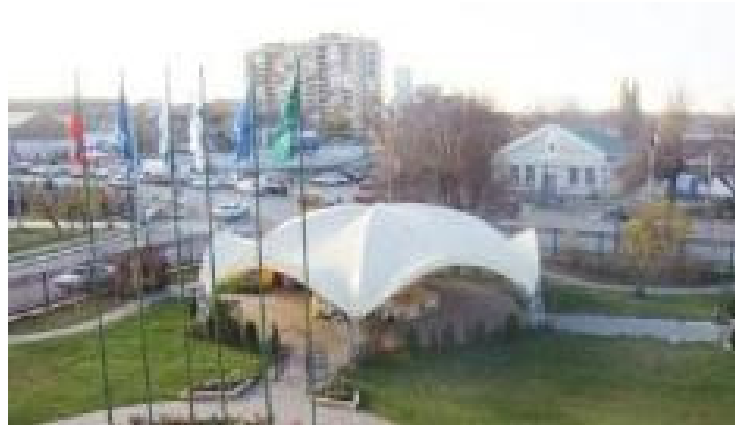
Рис. 4. Летнее кафе в форме гиперболического параболоида
