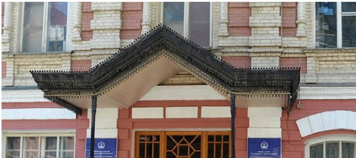
Рис. 6. Козырек над входом
