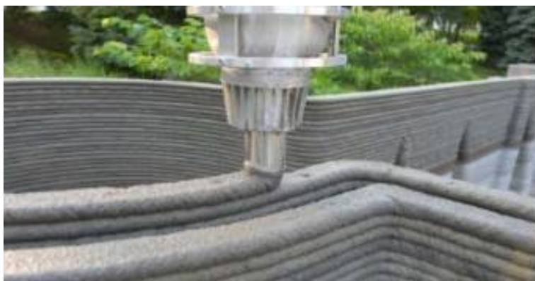
Рис. 2. Процесс построения по технологии ConcretePrinting
