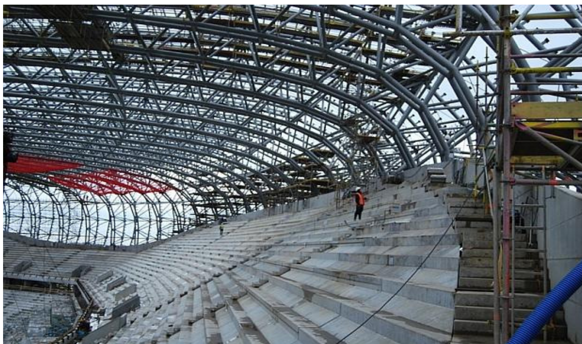
Рис. 1. Общий вид конструкций покрытия навеса над стадионом в Гданьске
