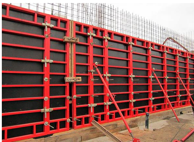
Рис. 1. Крупнощитовая опалубка DELTA
