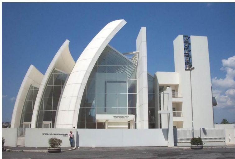
Рис. 1. Церковь из сборного железобетона в Риме
