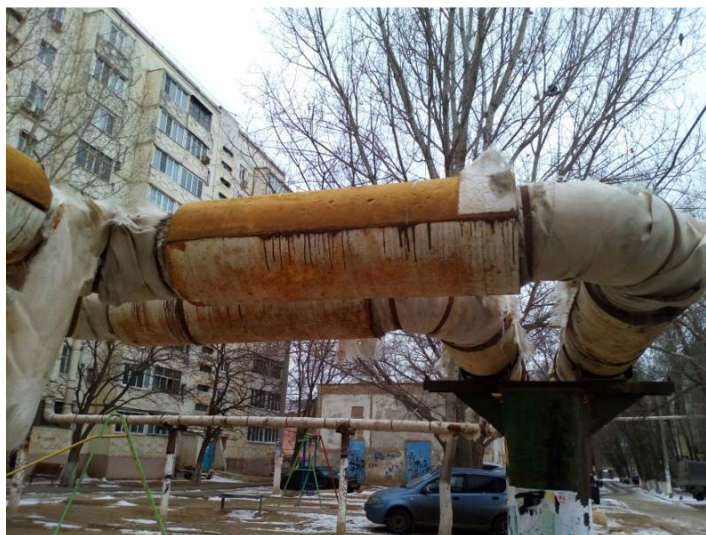
Рис. 4. Участок с качественной изоляцией
