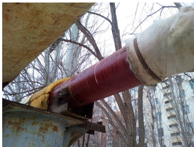
Рис. 2. Участок тепловой сети с повреждением
