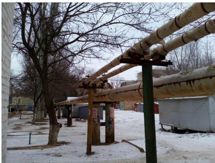
Рис. 3. Участок с качественной изоляцией
