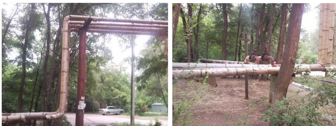
Рис. 1 Тепловая сеть от котельной до общежития
