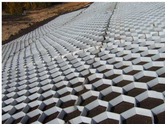
*Рис. 2. Полимерная геосинтетическая
