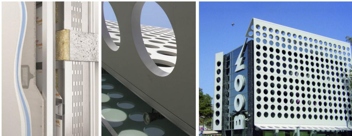
*Рис. 3. Торговый центр Voorn, г. Афины, Греция: разрез системы Кнауфаквапанель (слева), деталь фасада (по центру), общий вид здания (справа)*
