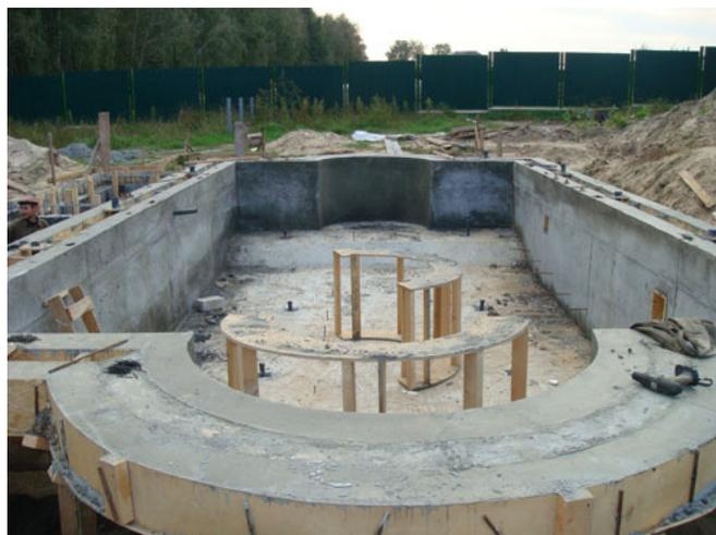
Рис. 2. Конструкция из железобетона – бассейн
