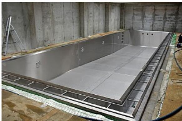
*Рис. 1. Установленный металлический бассейн*
