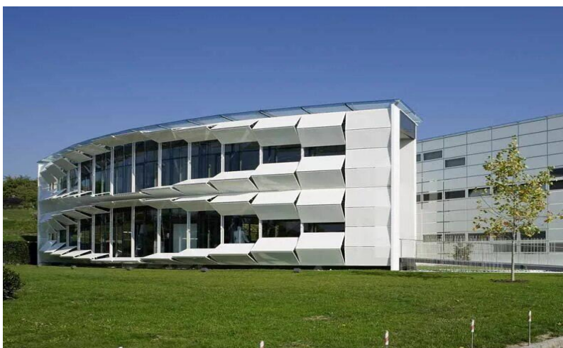
Рис. 1. Здание Kiefer Technic в Австрии [4]
