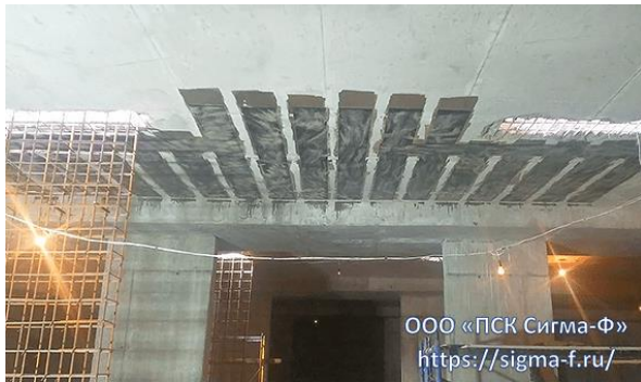
Рис. 5.2. Усиление монолитного перекрытия многоэтажного здания, г. Москва, 2022 год
