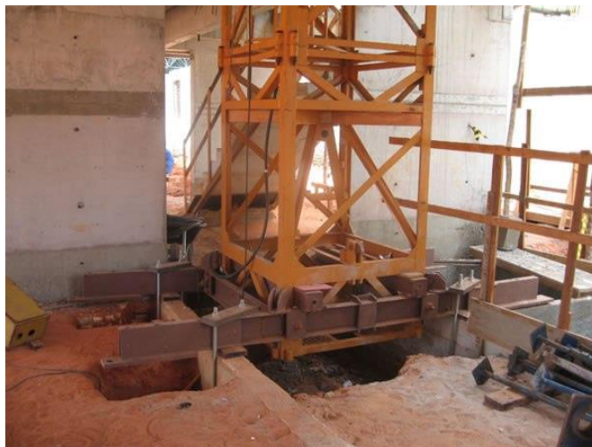
Рис. 2. Схема опирания опорных балок самоподъемного крана на конструкции каркаса многоэтажного здания
