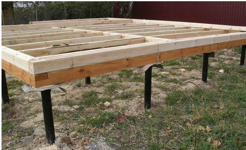
Рис. 2. Свайный фундамент
