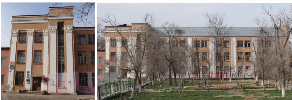
Рис. 4. Здание заводоуправления (фотофиксация 2013 г.)
