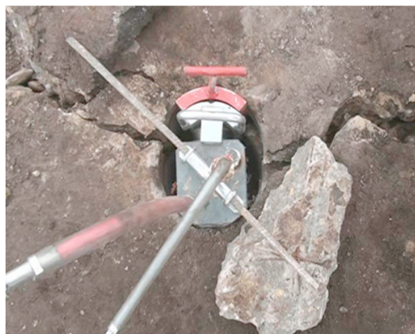
Рис. 2. Демонтажные работы гидроклином
