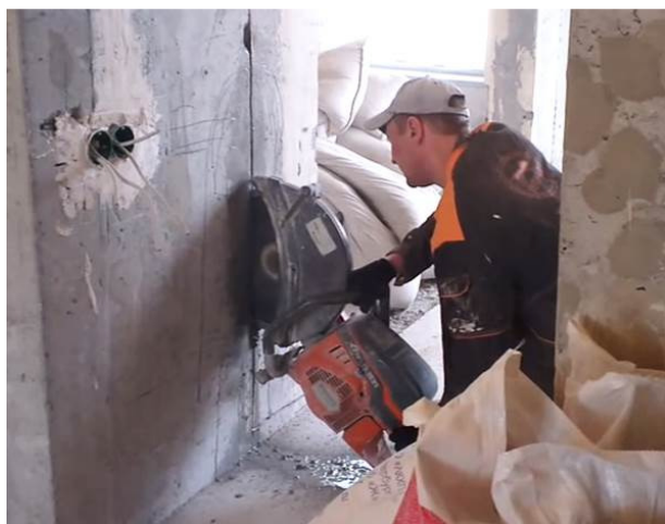
Рис. 1. Демонтажные работы алмазной резкой
