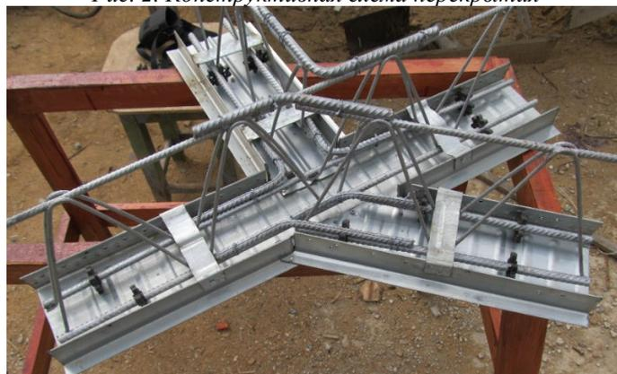
*Рис. 3. Стыковка балок под углом*
