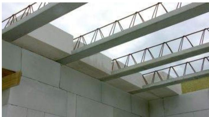
Рис. 1б. Сборно-монолитное перекрытие
