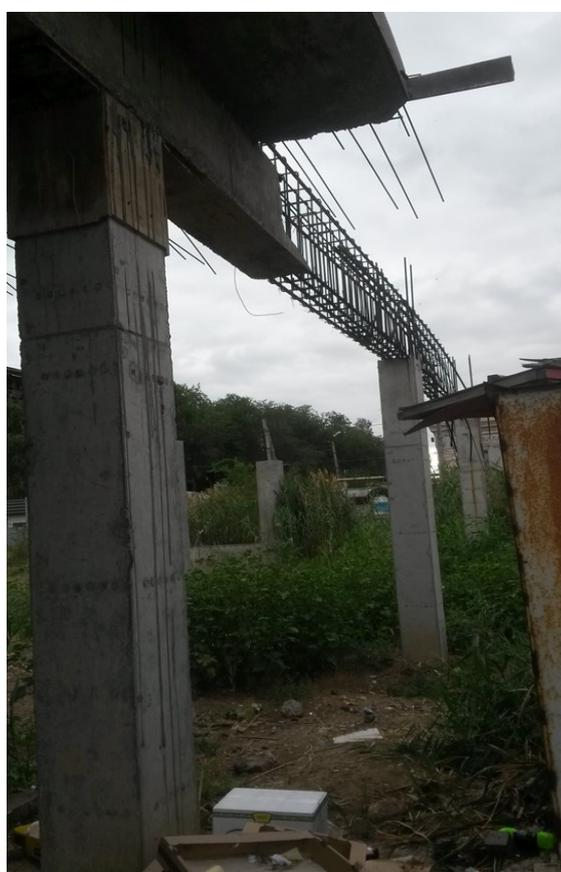
*Рис. 6. Балка Б-10. Арматурный каркас устроен с оси А до Д*
