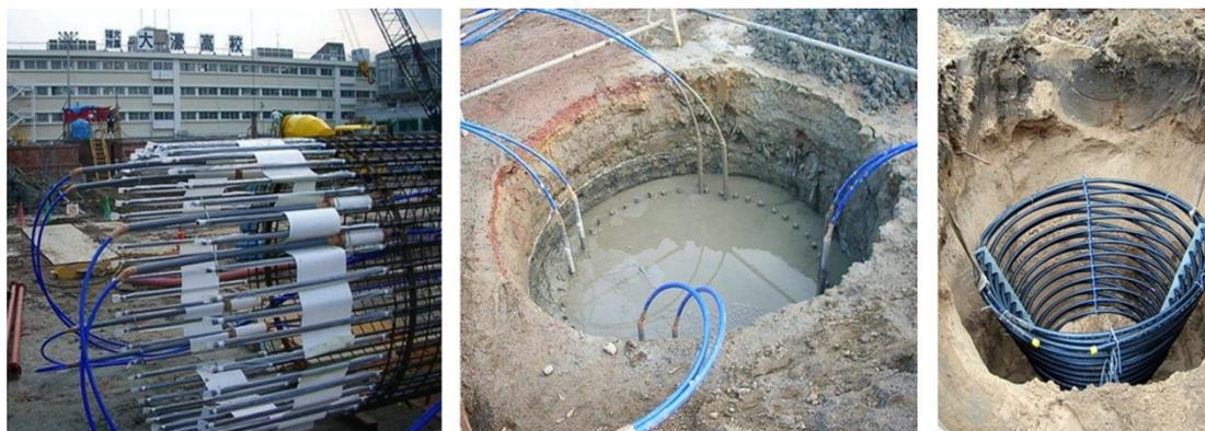
Рис. 2. Геотермальные коллекторы вертикального (слева и в центре) и корзиночного (справа) типов
