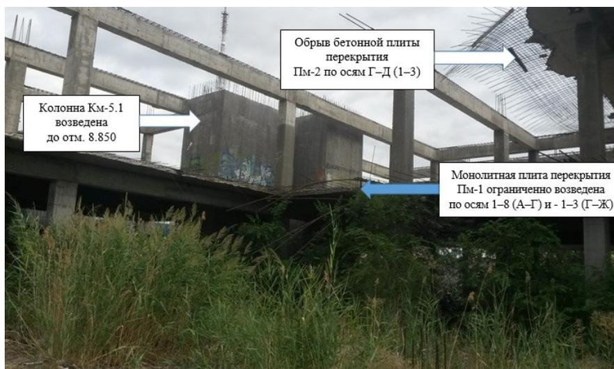
Рис. 3. Незавершенное двухэтажное строение торгового центра в осях А-Ж (1-8)
