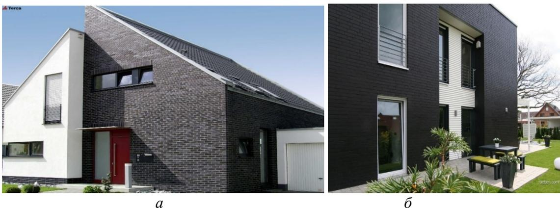
Рис. 2. Здания из полнотелого (а) клинкерного облицовочный кирпича черного цвета (TERCA Westminster) и пустотелого (б) клинкерный облицовочный кирпич черного цвета (Roben)
