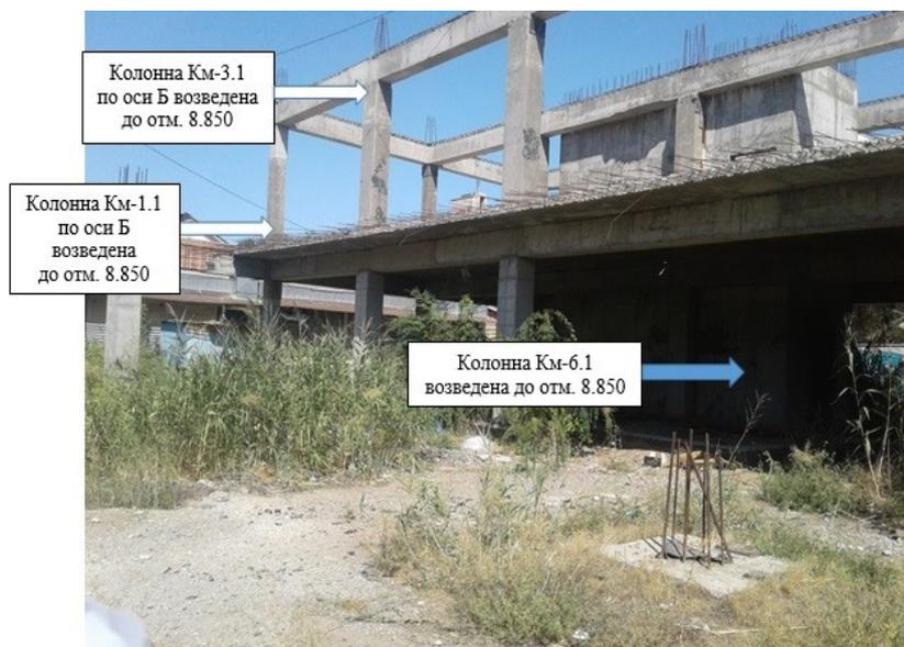
Рис. 1. Незавершенное 2-этажное строение торгового центра в осях А–В (5–8)
