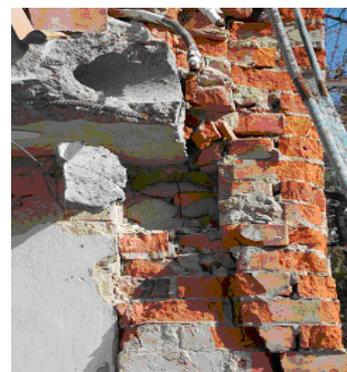
Рис. 4. Фрагмент смятия кирпичной кладки конструкций с торца здания
