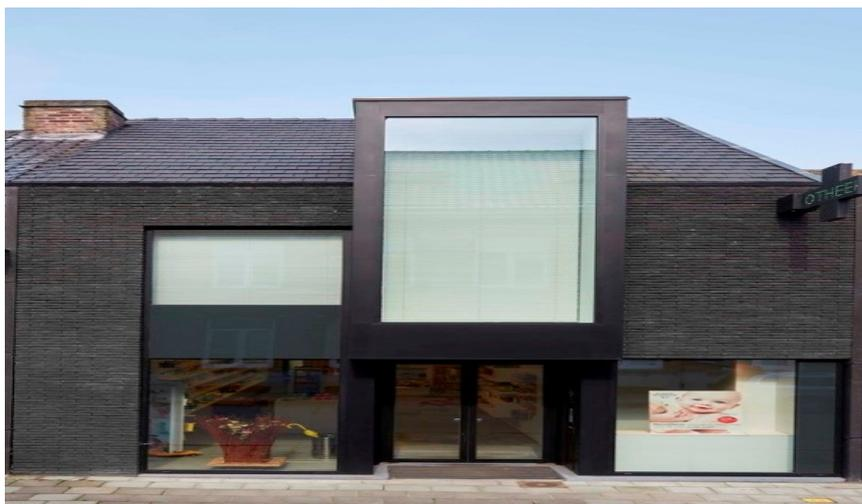
*Рис. 1. Облицовка здания черным клинкерным кирпичом в стиле хай-тек*
