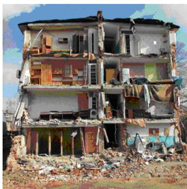
Рис. 3. Вид разрушенных конструкций с торца здания
