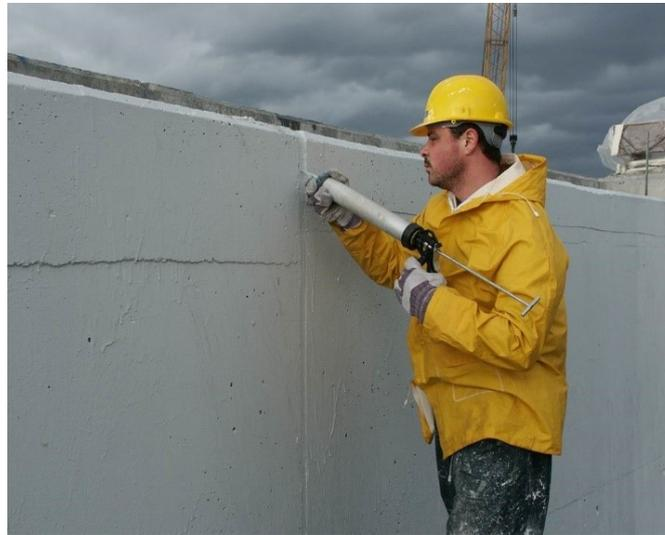
*Рис. 1. Схема заполнения деформационного шва*
