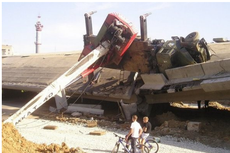
Рис. 1. Разрушение железобетонного моста в городе Екатеринбурге
