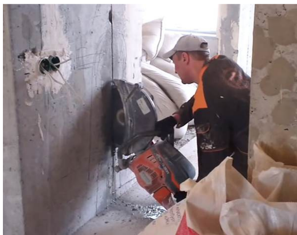
Рис. 1. Демонтажные работы алмазной резкой
