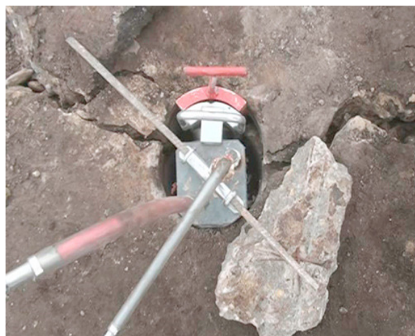
Рис. 2. Демонтажные работы гидроклином
