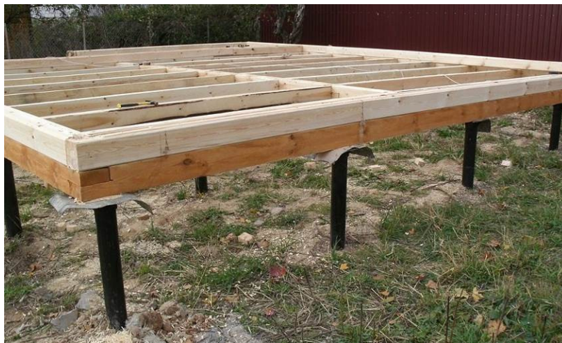
Рис. 2. Свайный фундамент
