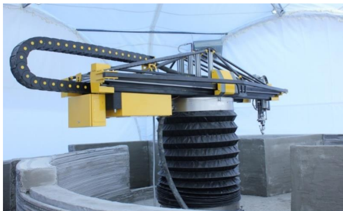
Рис. 2. 3D-принтер для строительства
