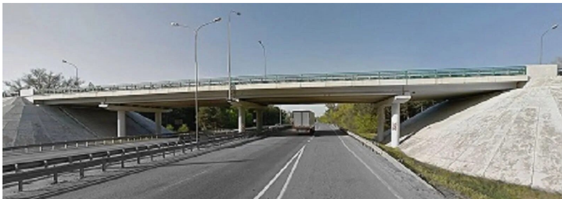
Рис. 4. Путепровод с уменьшенными крайними пролетами
