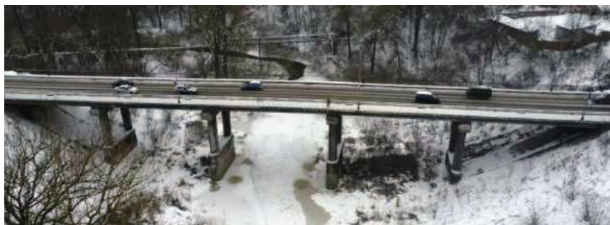
Рис. 1. Мост через реку Полота [источник: https://gorod214.by/new/9956 ] Fig. 1. Bridge over the Polota Rive [source: https://gorod214.by/new/9956 ]
