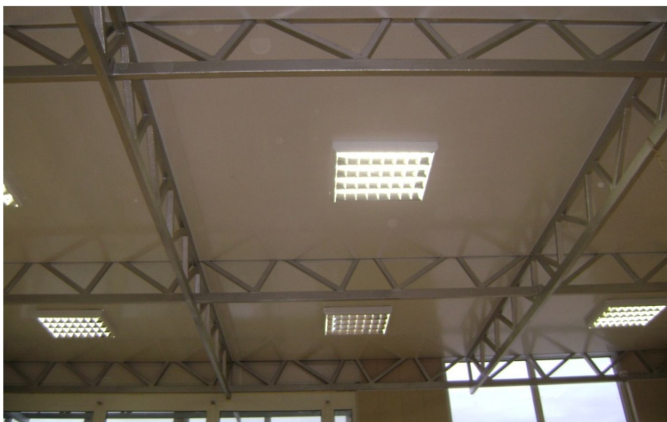
Рис 10. Снимки двухэтажных модулей при возведении складского строения ( a ) и блока перекрытия в интерьере офисного здания ( б )
