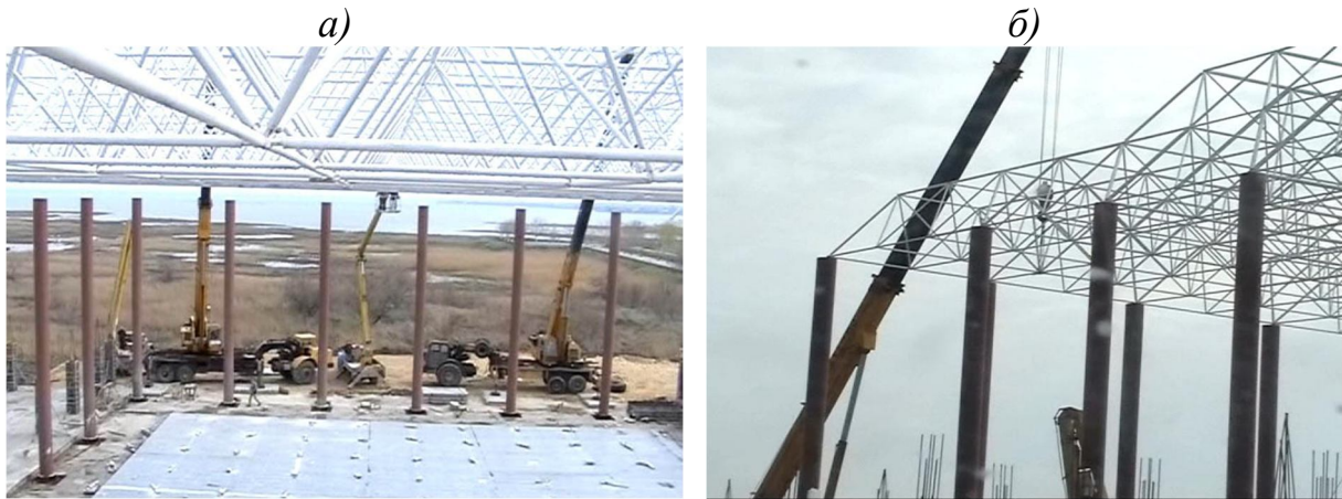
Рис. 3. Облегченная пространственно-стержневая конструкция покрытия в процессе монтажа: а – вид изнутри; б – вид снаружи
