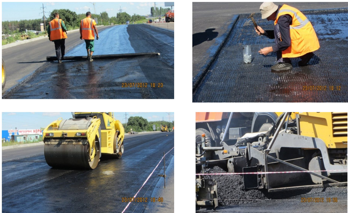
Рис. 3. Армирование асфальтобетонных покрытий на улице Антонова-Овсенко, г. Воронеж
