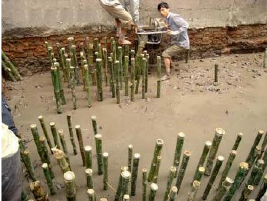
Рис. 1. Усиление слабых грунтов с помощью бамбуковых свай
