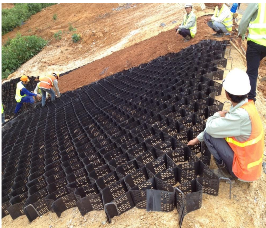
Рис. 3. Применение геоматериалов при строительстве автомобильных дорог
