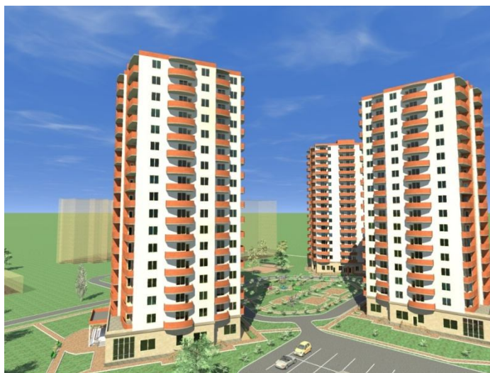
Рис. Общий вид строящегося жилого комплекса
