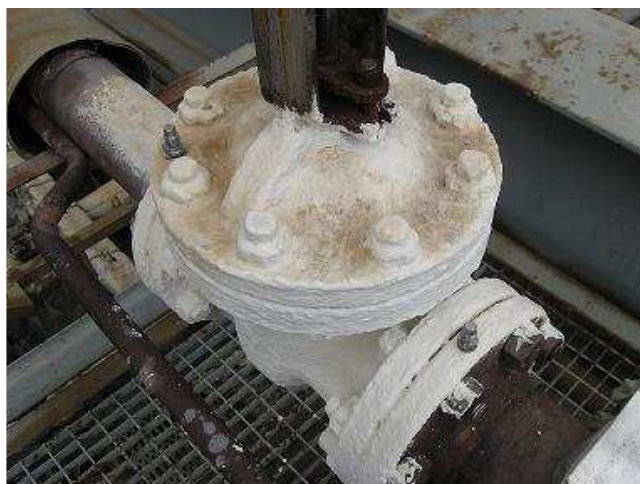
Рис. 2. Грязеудержание на теплоизолирующем покрытии «Корунд» после одного года испытаний в промышленной атмосфере Астраханского ГПЗ
