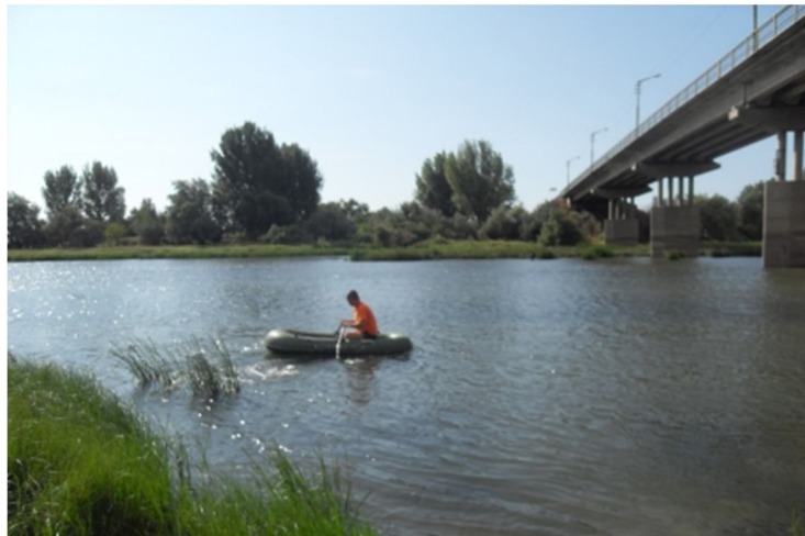
Рис. 1. Мостовой переход через р. Табола
