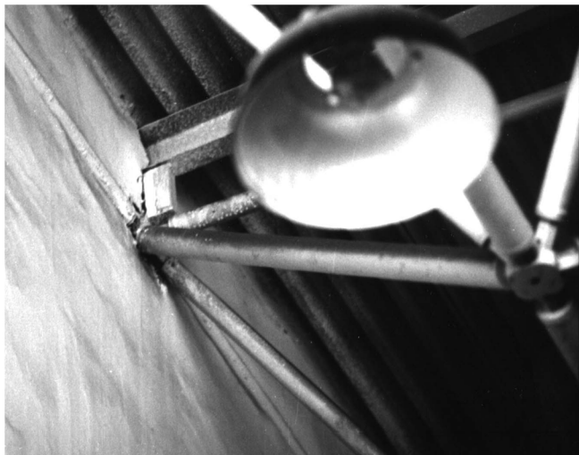
Рис. 1. Изменение расчетной схемы структурной плиты
