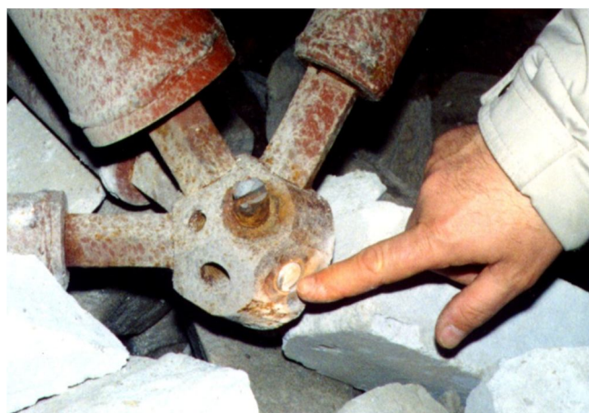
Рис. 2. Потеря несущей способности высокопрочного болта
