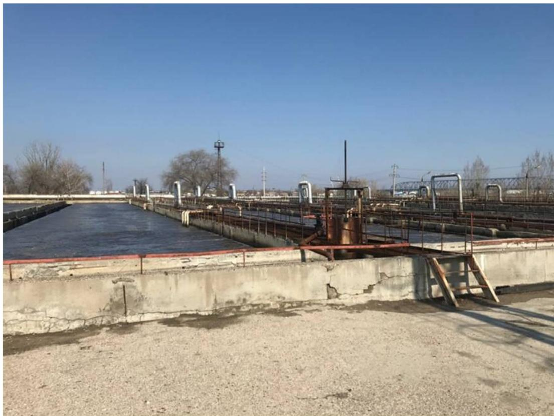
*Рис.2. Аэротенк на очистной канализационной станции*
