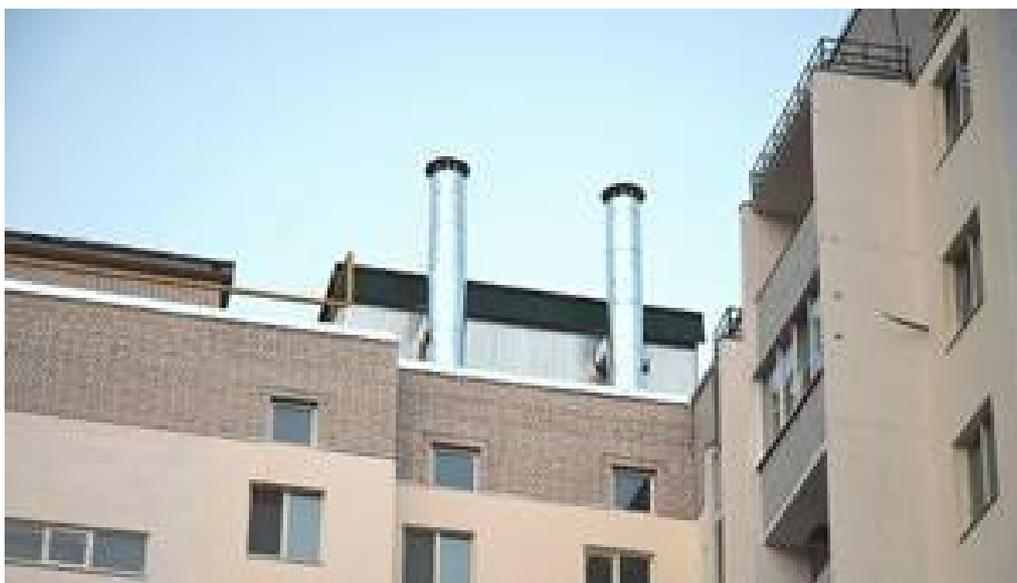
*Рис. 1. Крышная котельная, установленная на жилом доме*
