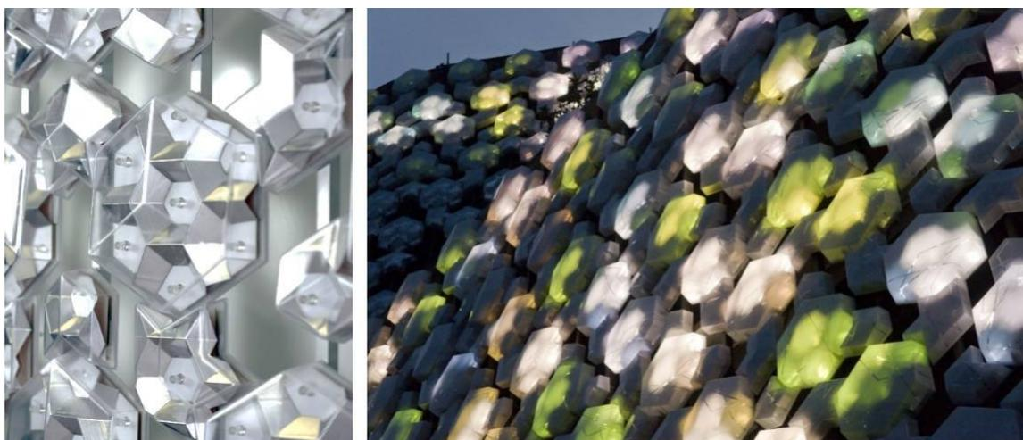
*Рис. 1. Фрагменты медиафасадов со светодиодами*
