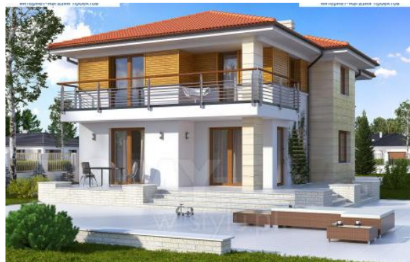
Усадебный жилой дом Вид №1
