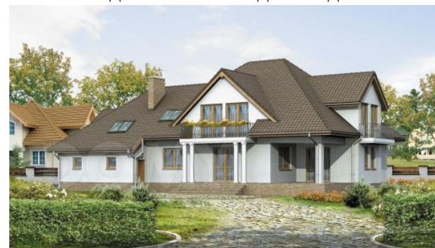
Усадебный жилой дом Вид №2
