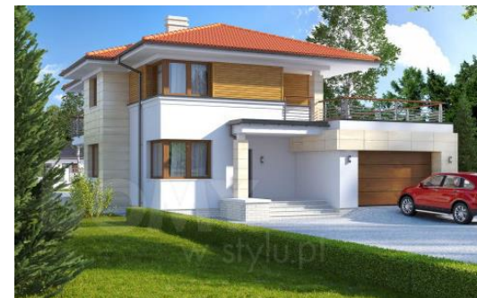
Усадебный жилой дом Вид №1
