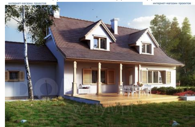
Усадебный жилой дом Вид №2
