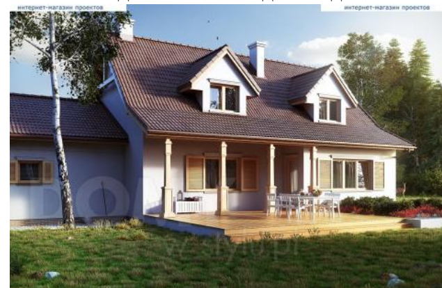
Усадебный жилой дом Вид №2
