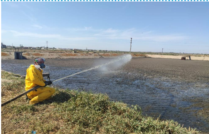
Внесение реагента Полиаминол методом орошения
