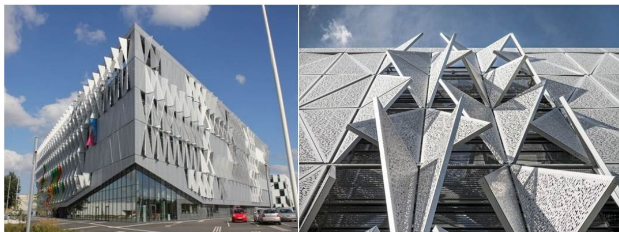
Рис. 2. Кампус Университета Южной Дании, г. Кольдинг. Фрагмент фасада справа
