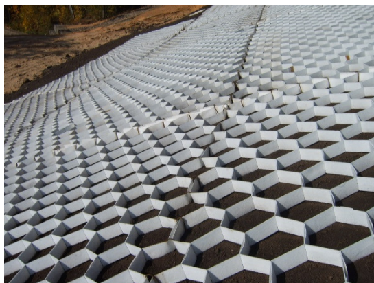
Рис. 2. Полимерная геосинтетическая решетка
