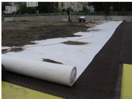
Рис. 1. Полотно нетканое геотекстильное
