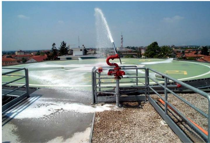
Рис. 2. Установка пенного пожаротушения взлетно-посадочной площадки
