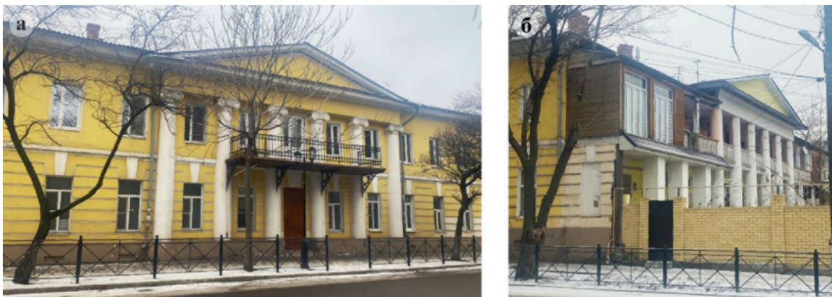
Рис. 3. Здание Полицейского управления (ул. Советская, 32): а) вид на главный фасад с улицы; б) дворовый фасад с галереей. Фото А. Е. Нехорошевой, 25 января 2025 г.
