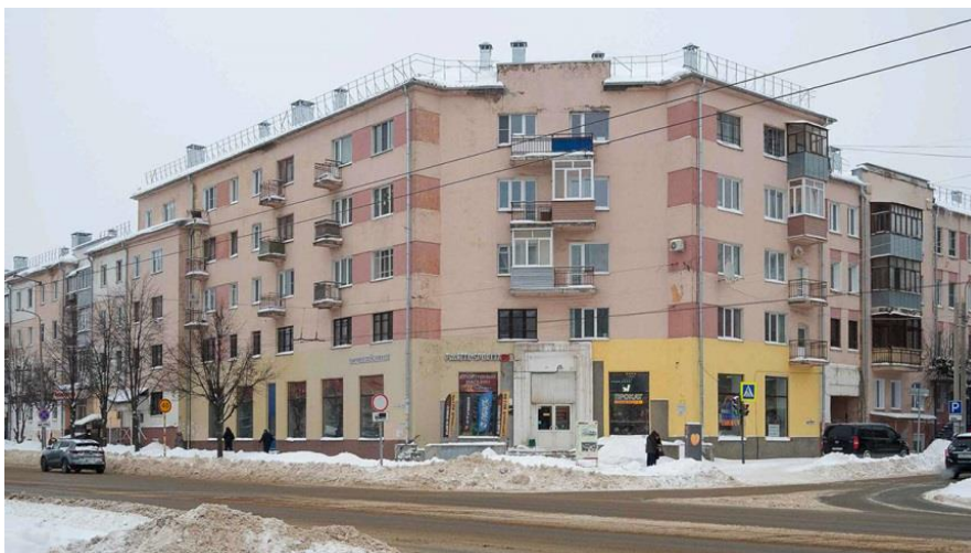
Рис. 8. Дом № 102 по пр. Ленина в Иванове, входящий в состав достопримечательного места «Александровская улица», последняя четверть XIX в. – 1950-е гг. Пример здания с хаотичным остеклением балконов в достопримечательном месте, где остекление балконов запрещено. Фото А. С. Никулина
