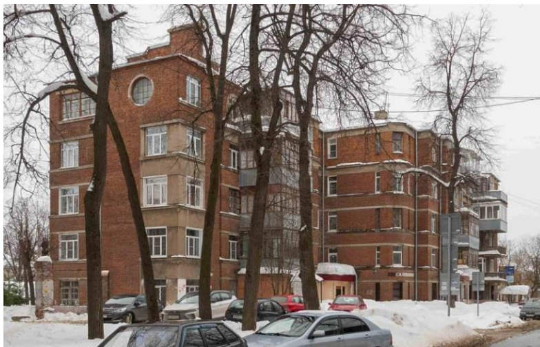
Рис. 6. Дом № 8 на Комсомольской улице в Иванове, входящий в состав сразу двух достопримечательных мест: «Александровская улица», последняя четверть XIX в. – 1950-е гг., и «Комплекс жилых домов треста “Ивтекстиль”, 1929–1938 годы, архитектор С. Н. Грузенберг». Фото А. С. Никулина
