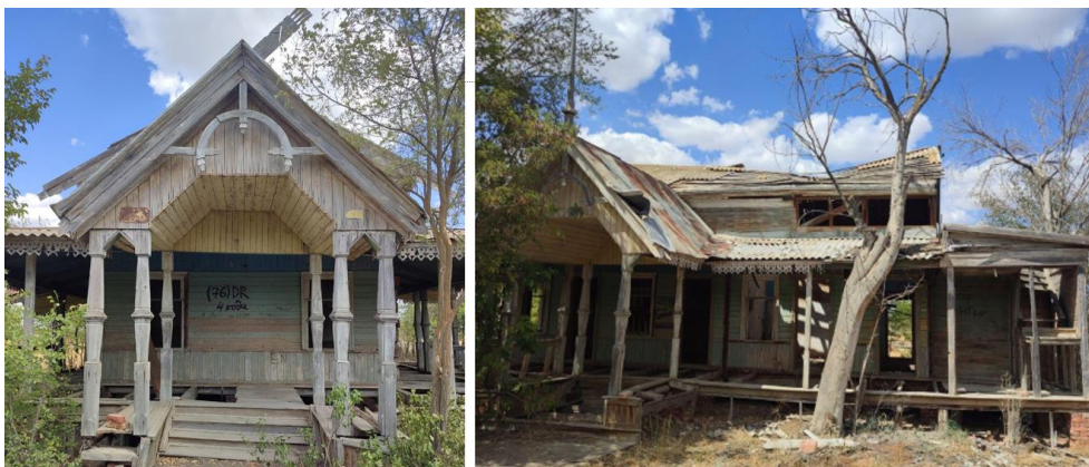
Рис. 10. Жилой спальный корпус, который был введен в эксплуатацию в 1913 г. (фото 2024 г.)
