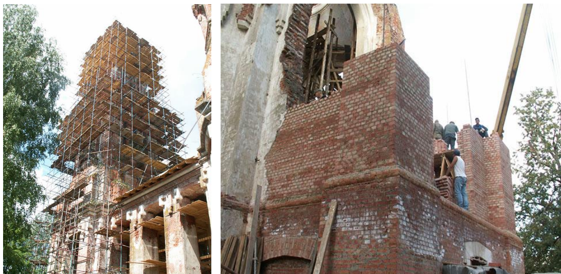
Рис. 3. Этапы реставрационных работ
