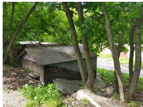
Рис. 6. Застройка территории оврагов (фото М. В. Булановой)
