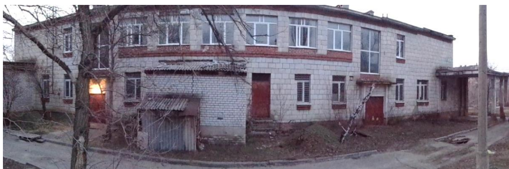
Рис. Общий вид объекта исследования
