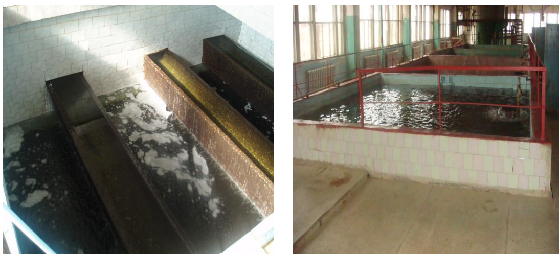
Рис. 2. Скорые фильтры Ахтубинского группового водопровода
