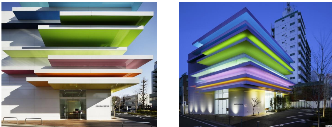
Рис. 1. Здание центрального банка Sugamo Shinkin в Токио
