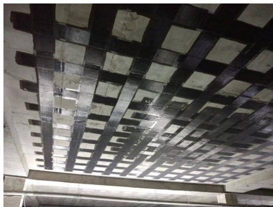
Рис. 4. Усиление монолитного перекрытия углеволокном
