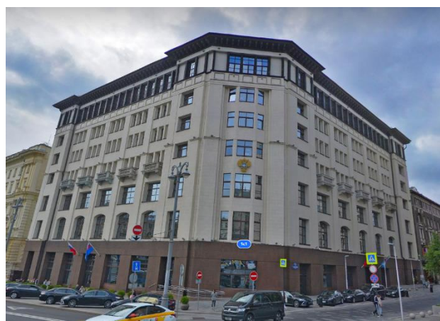
Рис. 8. Фасад после реконструкции
