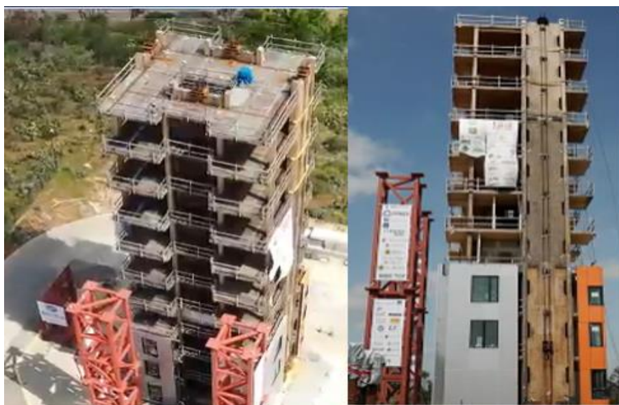
Рис. 1. Сан-Диего, 10-этажное здание из CLT-древесины в 2023 году возвели и протестировали его на вибростенде, создав имитации землетрясений 1994 года в Лос-Анджелесе магнитудой 7,7 [1]
