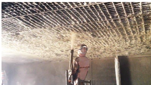
Рис. 5. Торкретирование монолитного перекрытия
