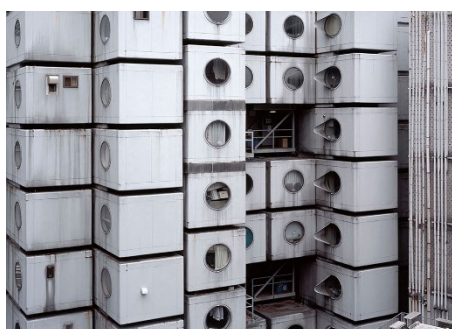
Рис. 1. Многоэтажное модульное здание
