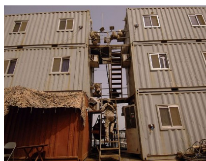
Рис. 2. Модифицированные транспортные контейнеры используемые в строительстве
