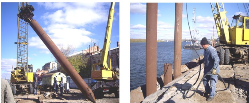
Рис. 5. Погружение вибровдавливанием металлических оболочек – труба O630 I = 13400 мм при берегоукреплении и благоустройстве центральной набережной р. Волга
