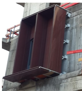
а) фрагмент ограждающей конструкции (внешней стены)
