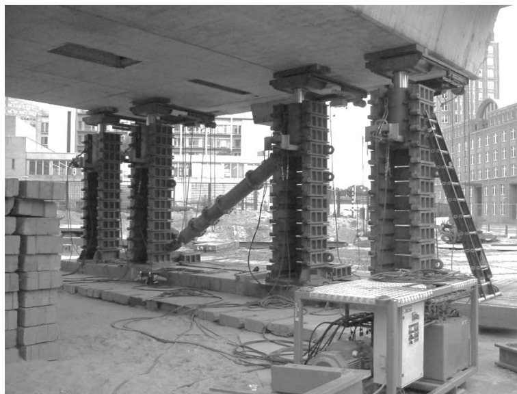
Рис. Гидравлические домкраты, используемые подъема тяжелого здания
