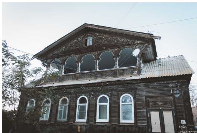
Рис. 1. Памятник архитектуры «Городской особняк», г. Астрахань
