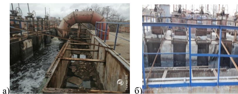
Рис. 1. Приемная камера (а) и решетки (б)
