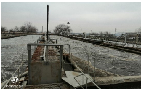
Рис. 3. Аэротенки
