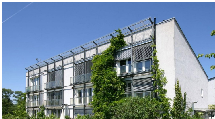
Рис. 2. Энергоэффективное здание Passivhaus (Германия, 1991 г.)
