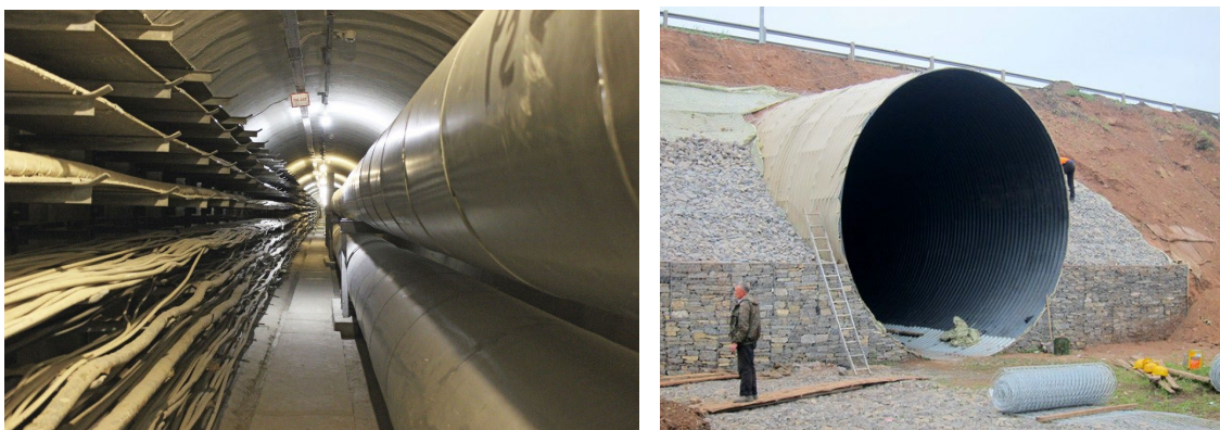
Рис. 4. Общий вид коммуникационного тоннеля
