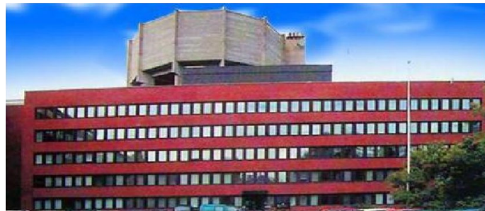
Рис. 1. Энергоэффективное здание EKONO-house (Финляндия, Отаниеми, 1973 г.)
