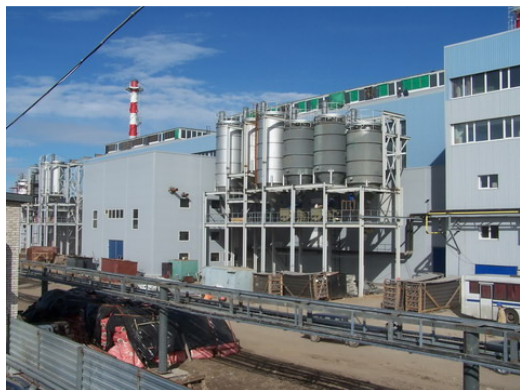
Рис. 6. Завод по сжиганию мусора, г. Санкт-Петербург
