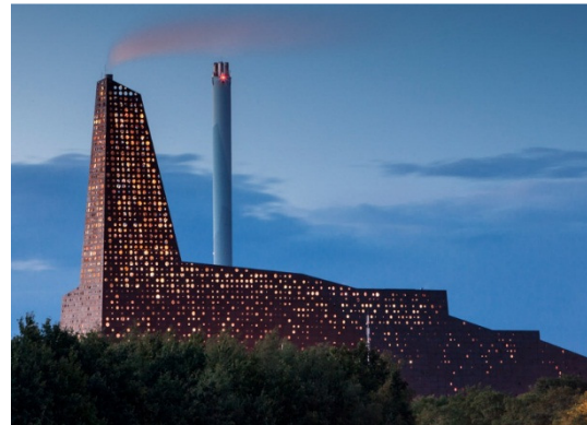
Рис. 4. Мусоросжигательный завод, Дания
