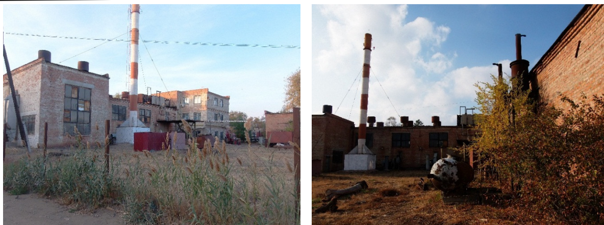
Рис. 4. Виды судоремонтного завода им. 30-летия Октября
