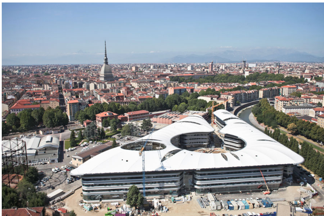
Рис. 2. Новый кампус Туринского университета от Foster + Partners
