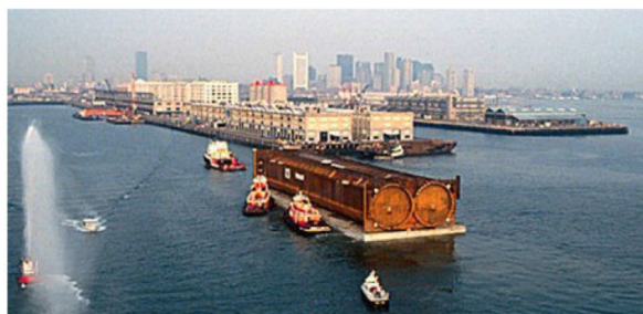
Рису. 12. Транспортировка стальных секций тоннеля (Бостон)
