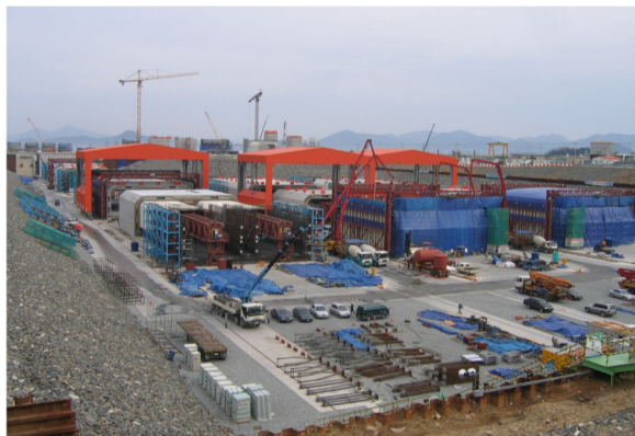
Рис. 9. Вид площадки для одновременной отливки нескольких секций тоннеля (западный берег залива Jinhae)
