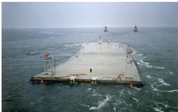
Рис. 11. Транспортировка железобетонной секции к месту погружения (Нидерланды)
