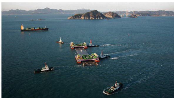
Рис. 15. Погружение секций со специальной баржи
