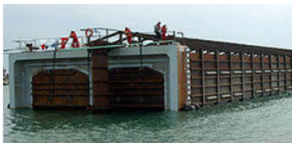
Рис. 13. Транспортировка сталебетонной секции (Турция)
