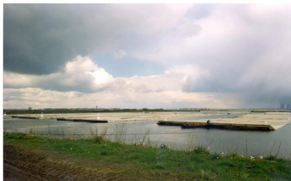
Рис. 10. Секции тоннелей, подготовленные для транспортировки (Нидерланды)
