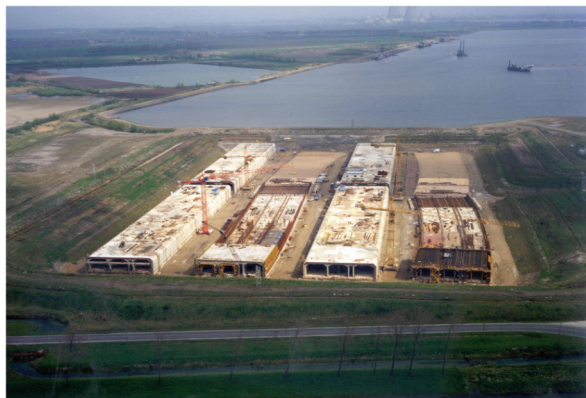
Рис. 8. Сооружение секции тоннелей в специальном котловане (Нидерланды)
