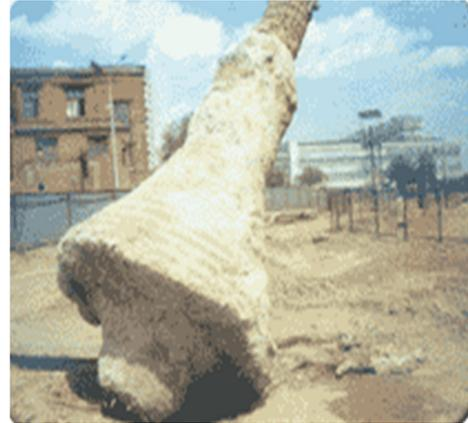
Рис. 6. Общий вид буронабивной сваи с уширением в форме полусферы, образованным разбуhrиванием грунта расширителем
