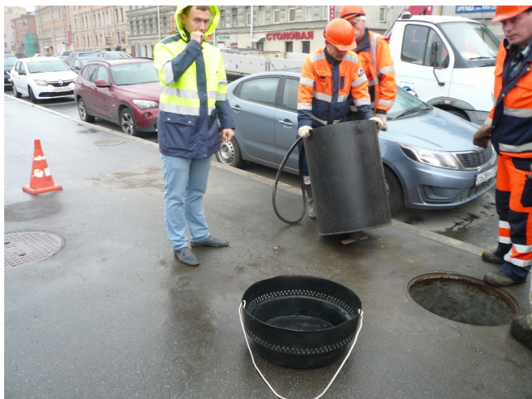
Рис. 2. Монтаж ЛОС с комбинированной загрузкой
