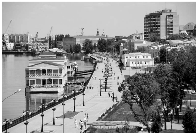
Рис. 1. Общий вид набережной после реконструкции
