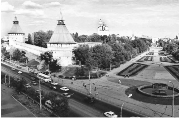
Рис. 5. Площадь им. Ленина до реконструкции
